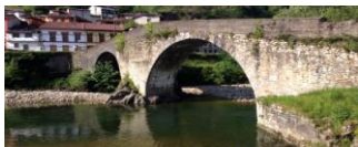
PUENTE DE ARCO
