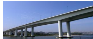
PUENTE DE VIGA
