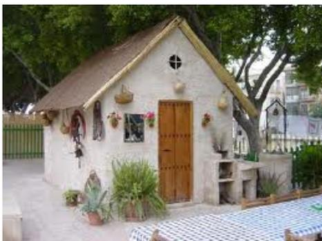
Tiene paredes de **adobe** (barro mezclado con paja) pintadas de blanco, techo de paja y caña, y ventanas pequeñas para que no entre mucho calor en verano. Ya no hay barracas en Murcia, solo se construyen algunas para las fiestas.
